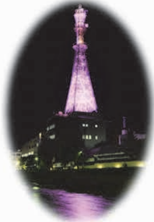
10月1日～7日：東北電力鉄塔
