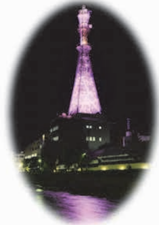
10月1日～7日:東北電力鉄塔
